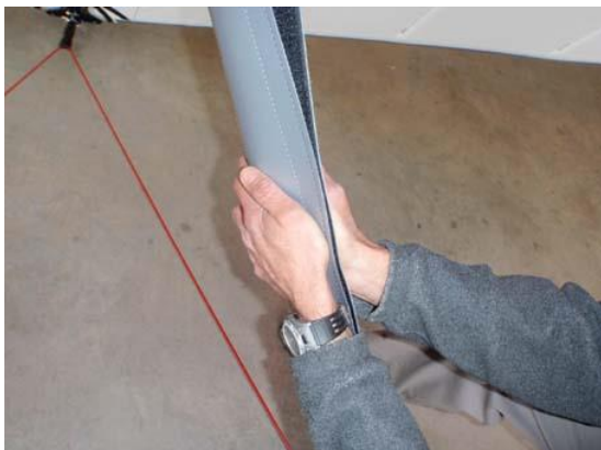
Figure 5-5 : Mise en place des profilages
